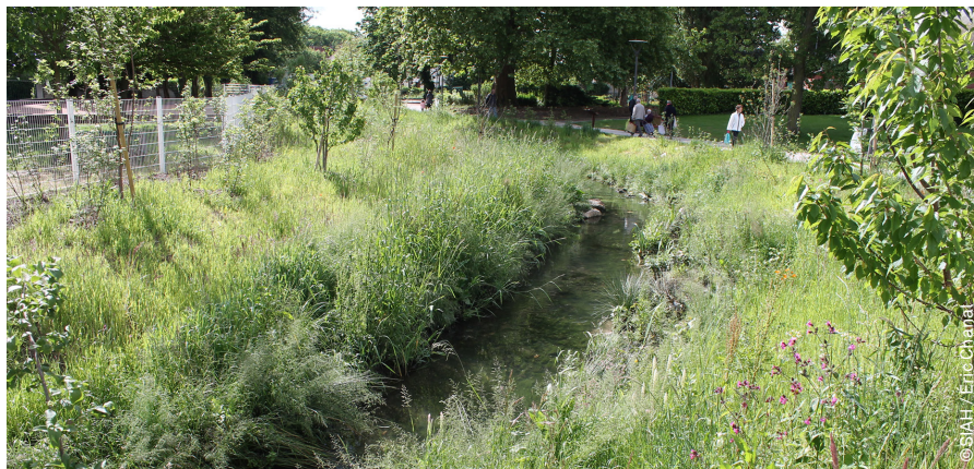
La végétation spontanée comme le recours à des plantes locales est un facteur essentiel pour la biodiversité des ouvrages de gestion des eaux pluviales. Le Petit Rosne à Sarcelles.
