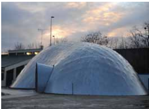
La cathédrale éphémère installée pendant le chantier (photo Yves Mernier)
