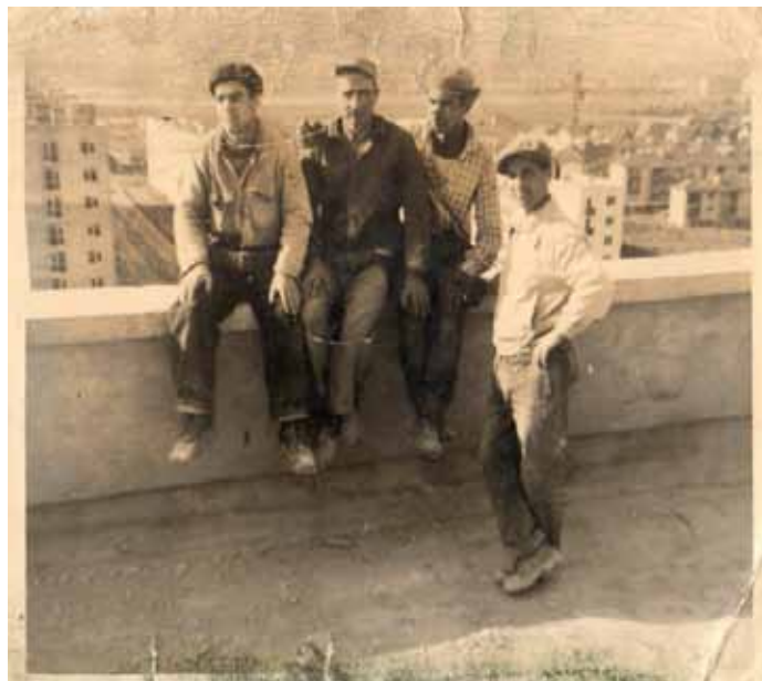
Antonio Sebastiani (le troisième en partant de la gauche), et ses amis sur un chantier au Mont-Mesly (photo famille Sebastiani)
