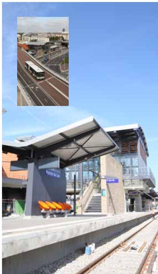
« Créteil-Pointe du Lac » en chantier (photo Michel Escuriol)
