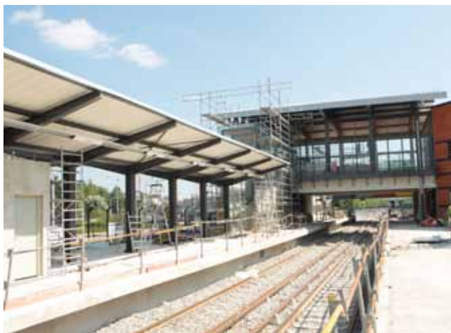
« Créteil-Pointe-du-Lac » en chantier (photo Michel Escuriol)
