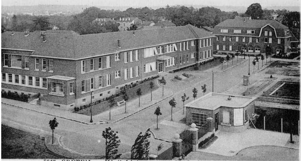
5017. CRETEIL — Hôpital intercommunal - La Maternité E. M.
