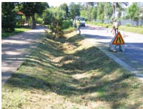
ZAC du Madrillet - Saint-Etienne-du-Rouvray - Entretien des noues de l'espace public
