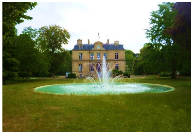
Figure 7: Bassin paysagé du parc de la mairie de Choisy-le-Roi (Source : Mairie de Choisy-le-Roi)
