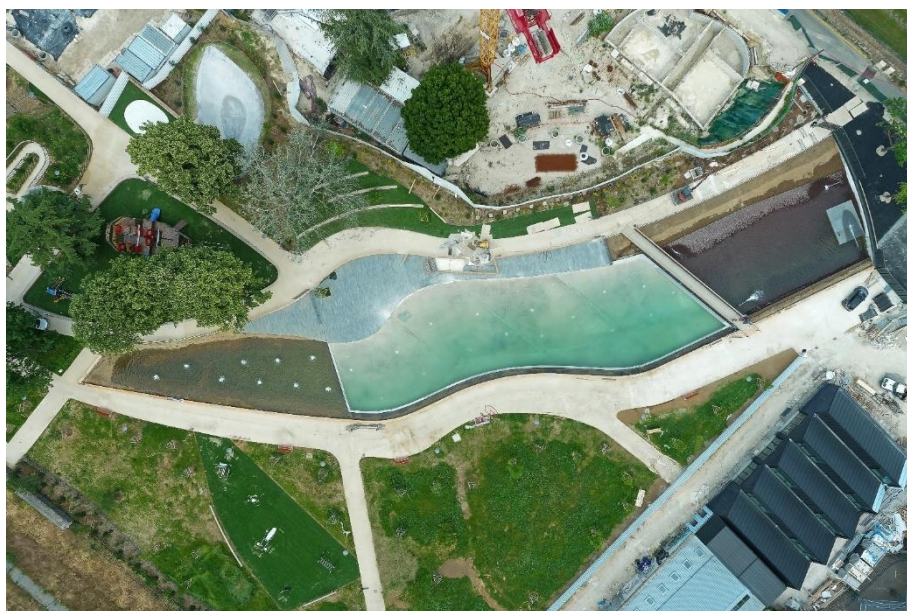
Figure 15 : Bassin du parc Diderot de la ville de Pantin (Source : Terideal)
